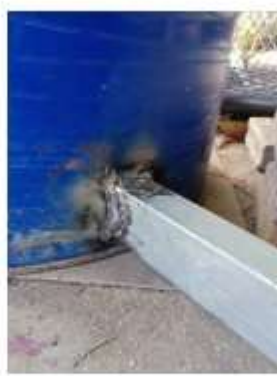
(ข) การเชื่อมเหล็กเข้ากับถังน้ำมัน
